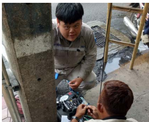
ภาพประกอบที่ 17. ทดลองติดตั้งชุดอุปกรณ์ Pigtail Round Type 3.5 mm. ที่ตู้ SDP
