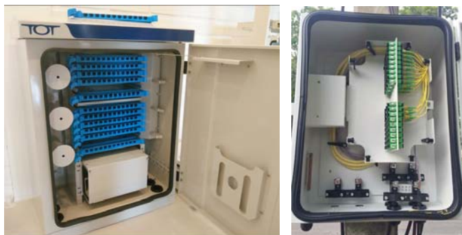
ภาพประกอบที่ 4. ตัวอย่างตู้ OFCCC หลากๆ รูปแบบที่ติดตั้งใช้งาน
