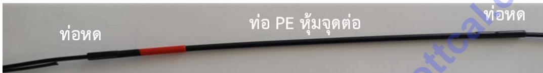
ภาพประกอบที่ 11. ขั้นตอนหุ้มอุปกรณ์ Pre-Heat Shrinkable Tube
