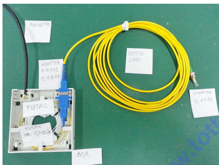
ภาพประกอบที่ 14. การต่อเชื่อมโยงเส้นใยแก้วนำแสงภายในอาคารก่อนเข้าอุปกรณ์ ONU/ONT
